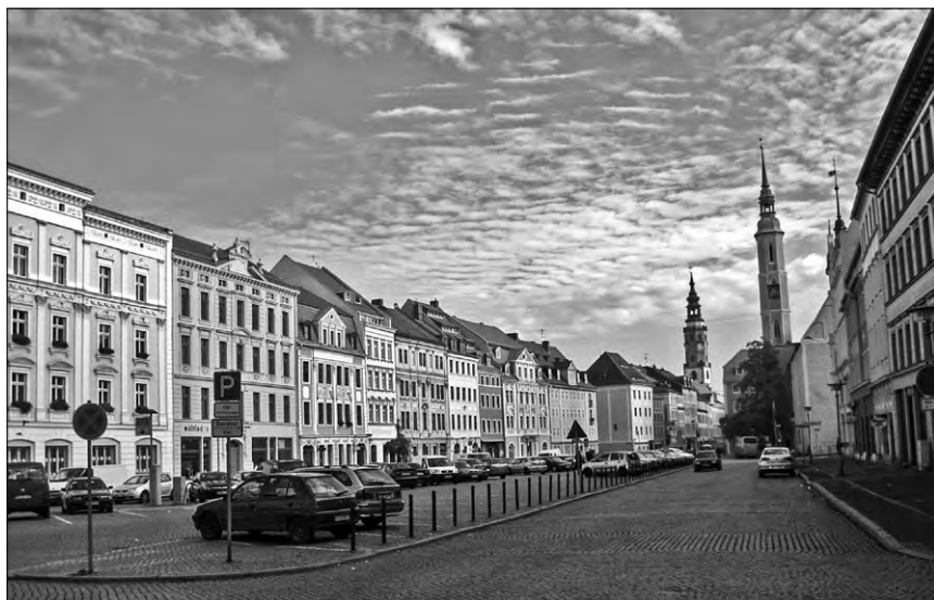
Náměstí Horní trh (Obermarkt) v Görlitz, vpravo štíhlá věž kostela svaté Trojice, v pozadí radniční věž. Foto: Martin Veselka
