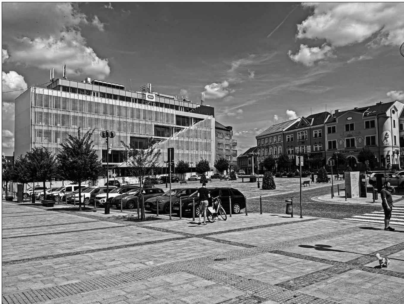
Někdejší Dolní náměstí, dnes T. G. Masaryka, hyzdí budova bývalého Okresního stavebního podniku, kvůli níž byla zbořena téměř celá jedna fronta domů. Foto: Martin Veselka
